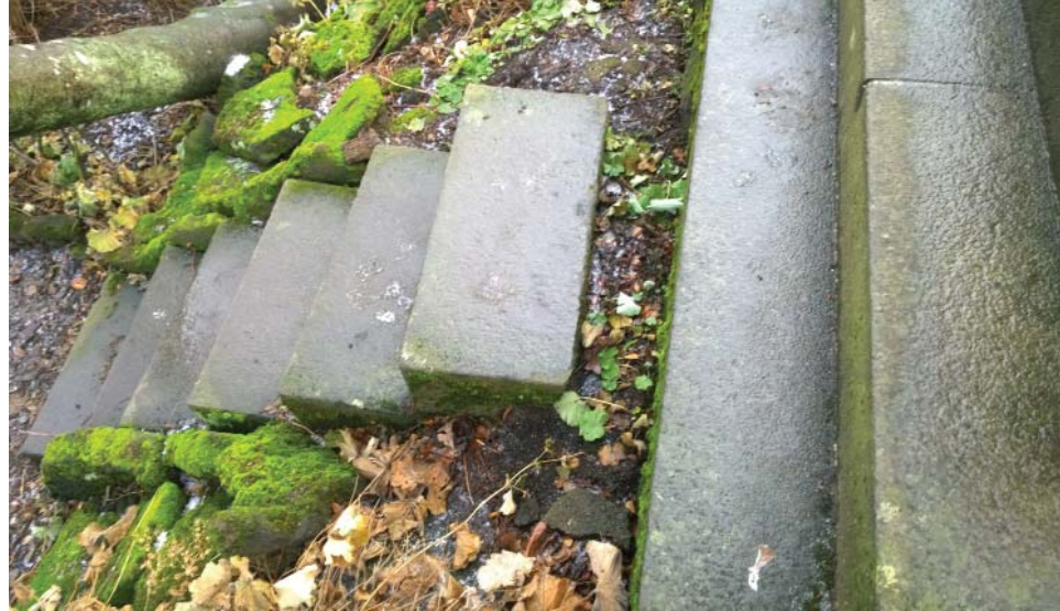
Tröppur hafa runnið til og skekkst. Þarf að lagfæra, ef til vill þarf að moka efni undan þeim og setja frostfrítt efni.
