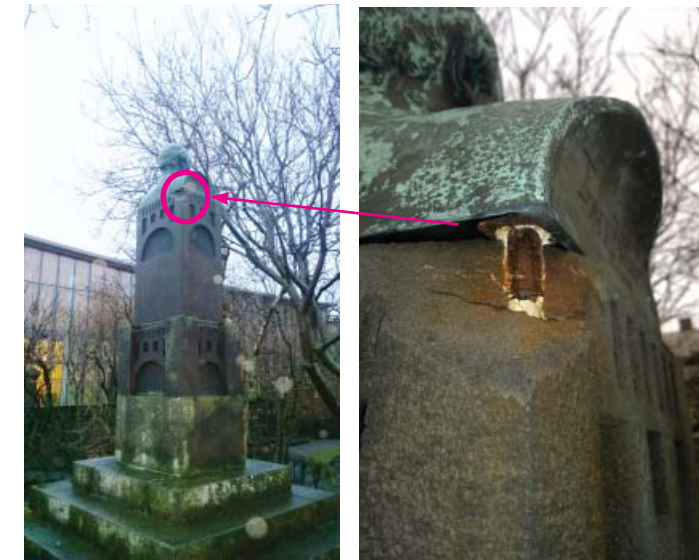
Hornið að undirsteininum hefur brotnað, líklega vegna þess að það er ryðgaður járnteinn sem festir hausmyndina, þar sem vatn hefur komist á milli og sprengt steininn.
